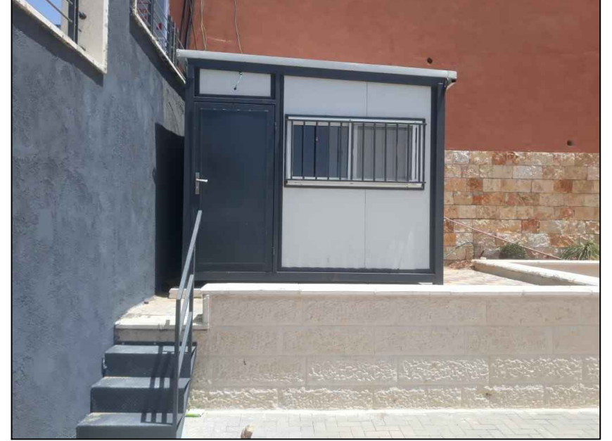
غرفة الحراسة المطلوبة
